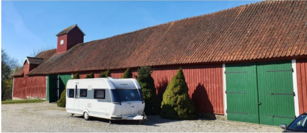
Figur 11. Logen sedd från nordöst. Bild från kulturmiljöutredning.
