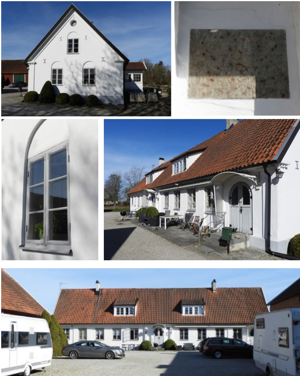
Figur 9. Mangårdsbyggnad sedd från söder. Bilder från kulturmiljöutredning.
