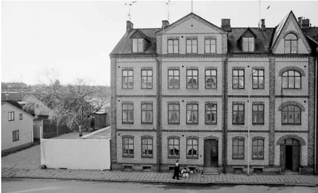
Figur 12. Byggnad på Sebran 37 - östra fasaden mot Västerlånggatan
