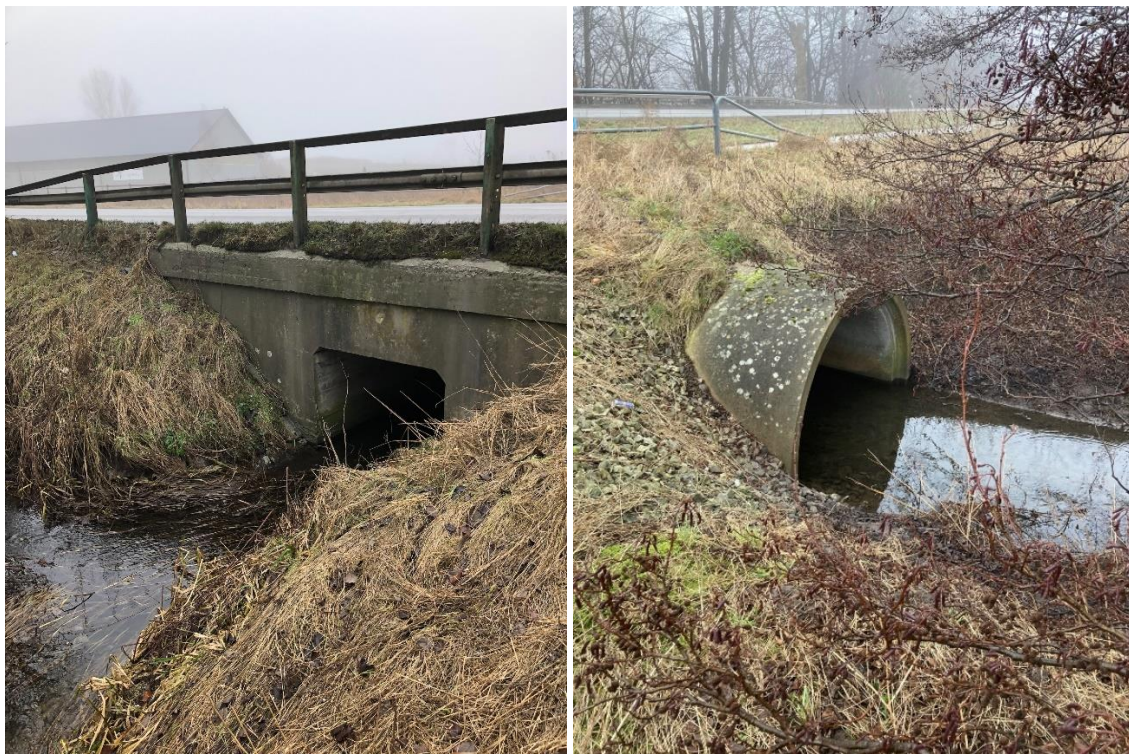
Figur 14. Brotrumma under Väg 104. T.v. sedd från norr, t.h. sedd från söder. Trumman är betydligt större än uppströms och nedströms trummor (Foto: Tyréns AB, från platsbesök 2022-01-18).
