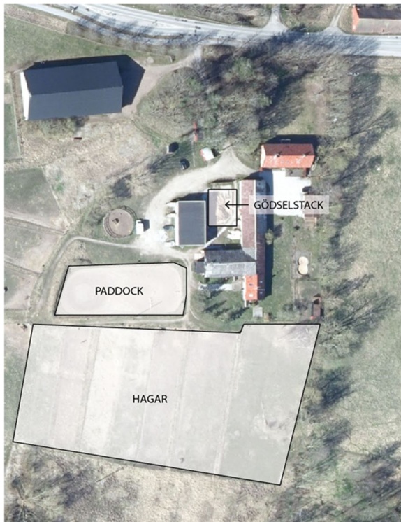
Figur 60. Ortofoto (2022) över den västra hästgården med utpekade ytor för hagar, paddock och gödselstack.
