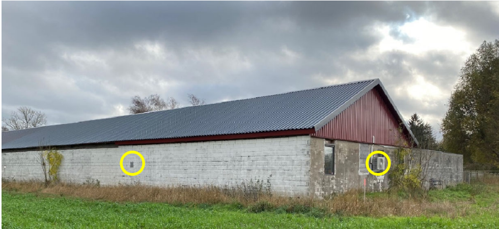
Figur 53. Foto på byggnaden där veterinärkliniken har sin hästmottagning, sett från nordväst. Gul markering visar var luftvärmepumpen och ventilationsuttaget finns.
