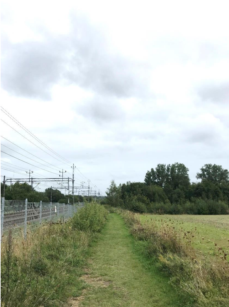
Foto på gångväg längs järnvägen. Bild: Radar
