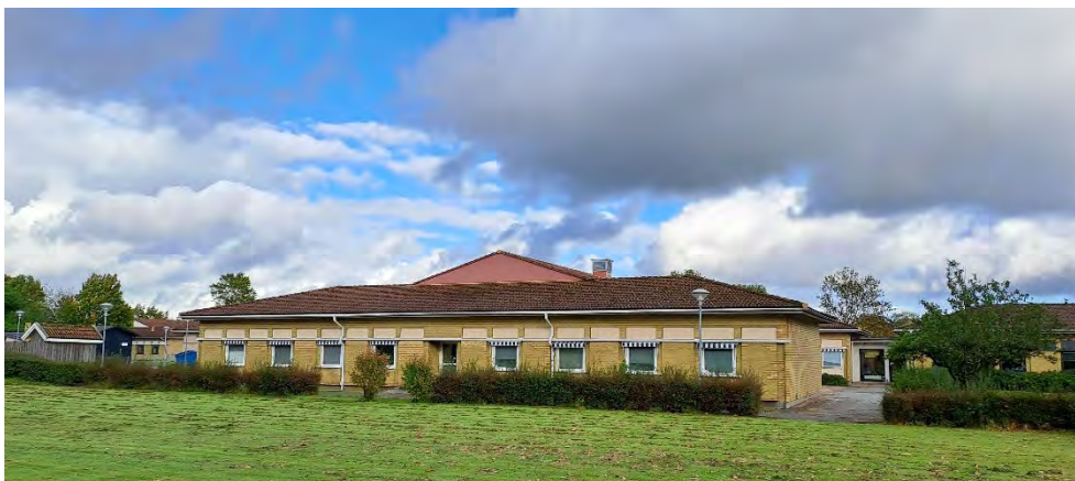
Figur 7. Foto på en av de befintliga byggnaderna med rött taktegel.
