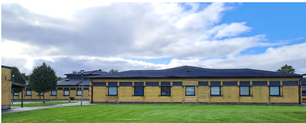
Figur 6. Foto på en av de befintliga byggnaderna med svart takpapp.
