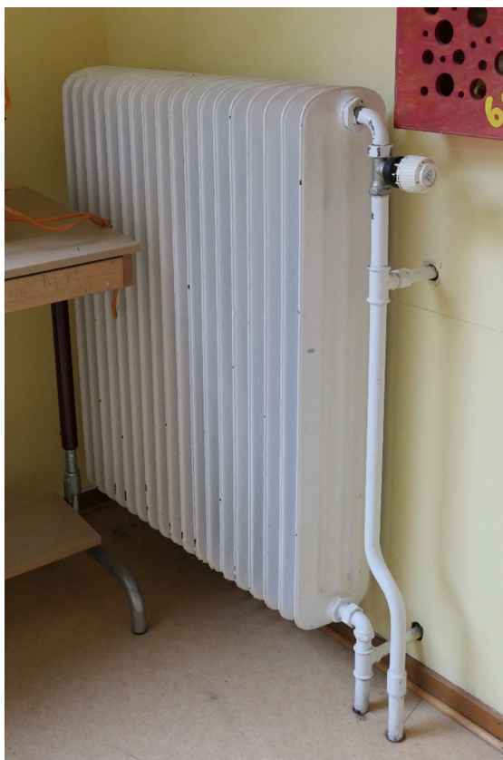
Äldre radiatorer i gjutjärn finns på ovanvåningen. Äldre skåp på ovanvåningen, som även påträffats i källaren.
