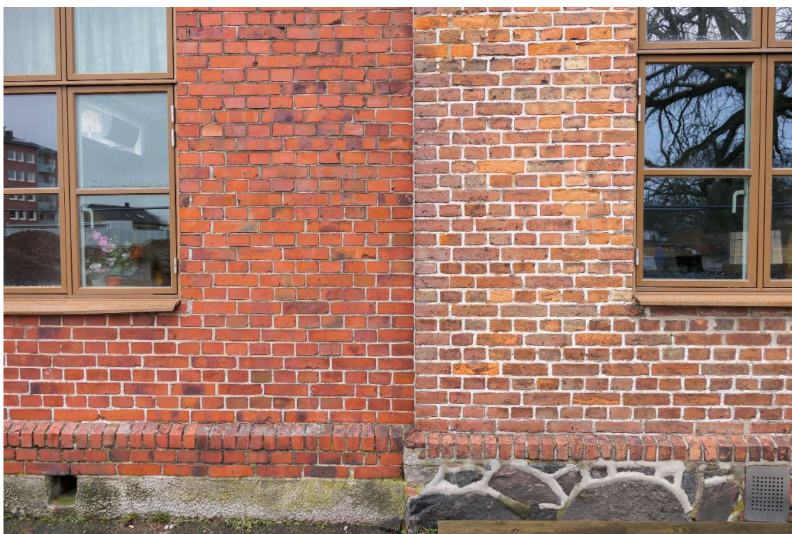
1958 års maskinslagna tegel bredvid 1876 års handslagna tegel.
