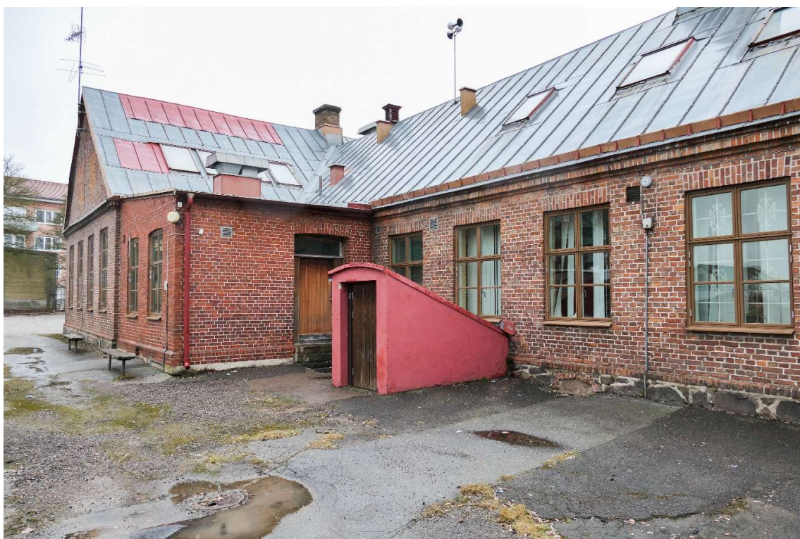
Baksidan åt söder med den västra flygeln och dess tillbyggnad från 1958 samt ingång ner till källare.
