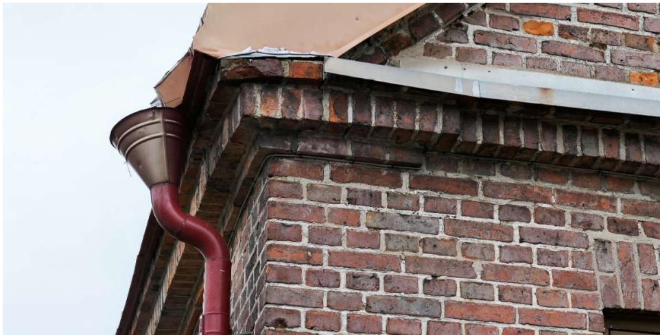
Takgesims på långsidorna övergår till en gördelgesims på gavlarna.
