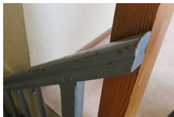
Trappa i trä med tidstypisk ledstång, möjligen har trappan lett upp till lärarnas bostäder på andra våningen.
