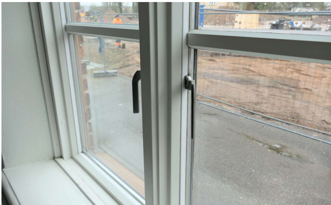
Fönstren invändigt, bågen och karm är av vitmålat trä.
