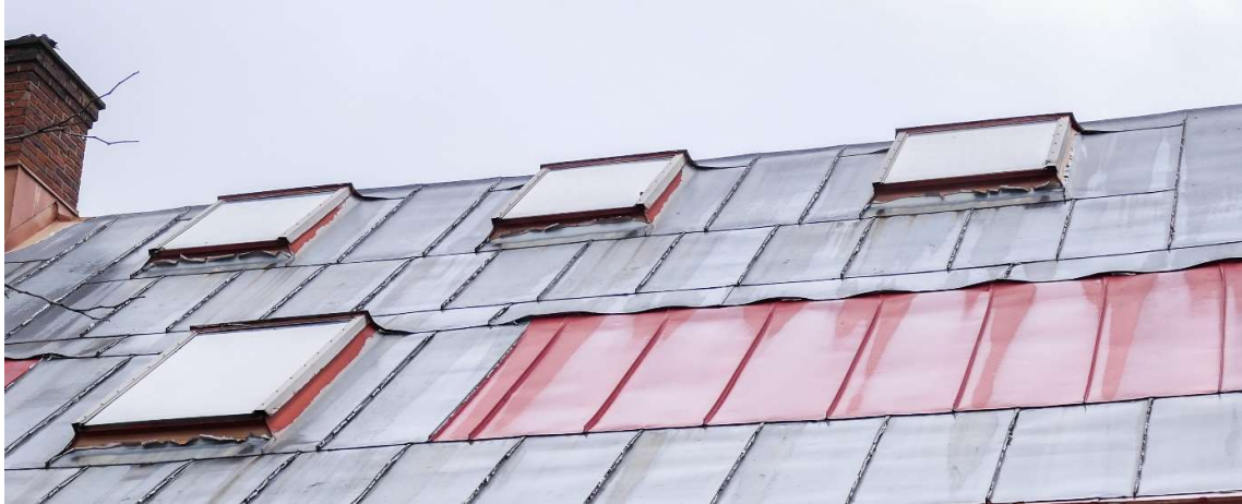
Takfönster från 1960-talet.
