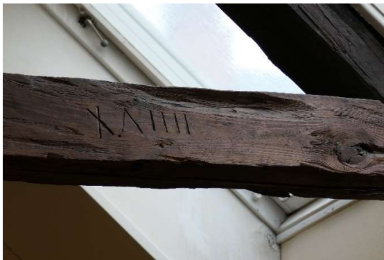
Äldre timmermärkning av takstol.
