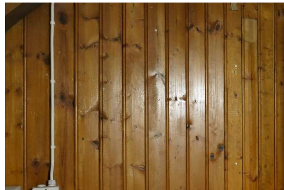
Bevarad pärlspontspanel i ett förrådsrum.
