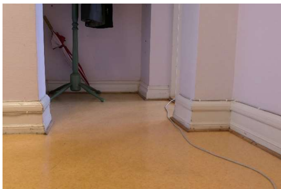
Äldre, profilerade golvlister i lärarrum.
