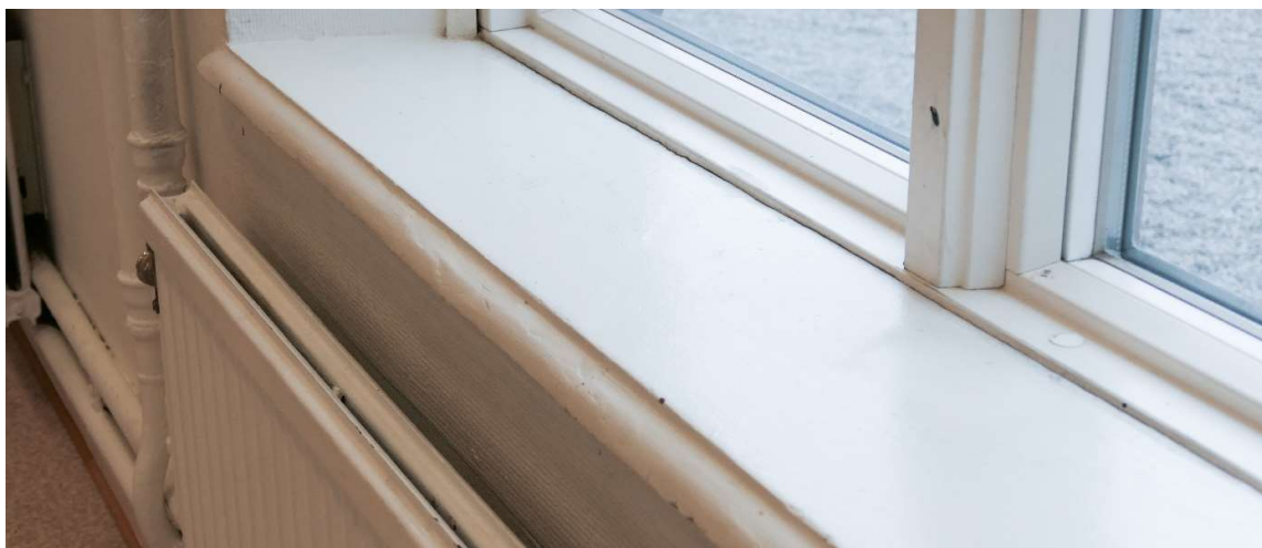
Fönsterbänkar i trä med profilerad kant.
