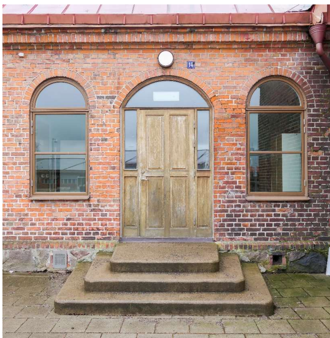
Rundbågiga fönster flankerar entrén placerad i ett segmentbågigt valv. Sentida dörr med sido- och överljus. Bild t h visar fönster på mittbyggnaden som är lägre än de på flyglarna.
