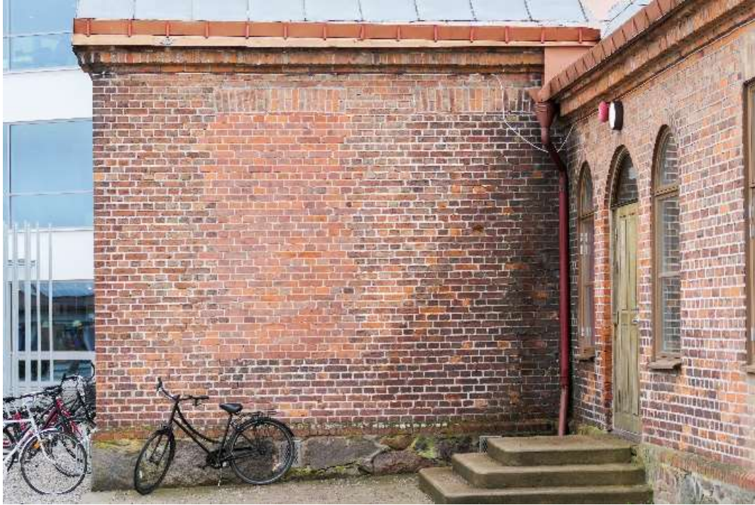
Igensatta fönsteröppningar på flyglarna.
