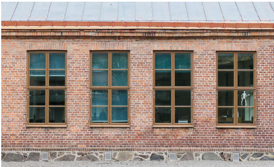
Fönstren består av fyrluftade flaggfönster med spröjs i trä/aluminium, insatta år xxxx.
