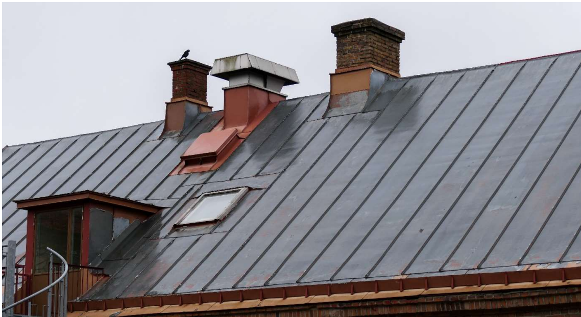
Västra takfallet belagt med plåt.
