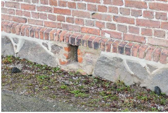
Sockel av huggen natursten. Höger bild visar den fasade fogen.
