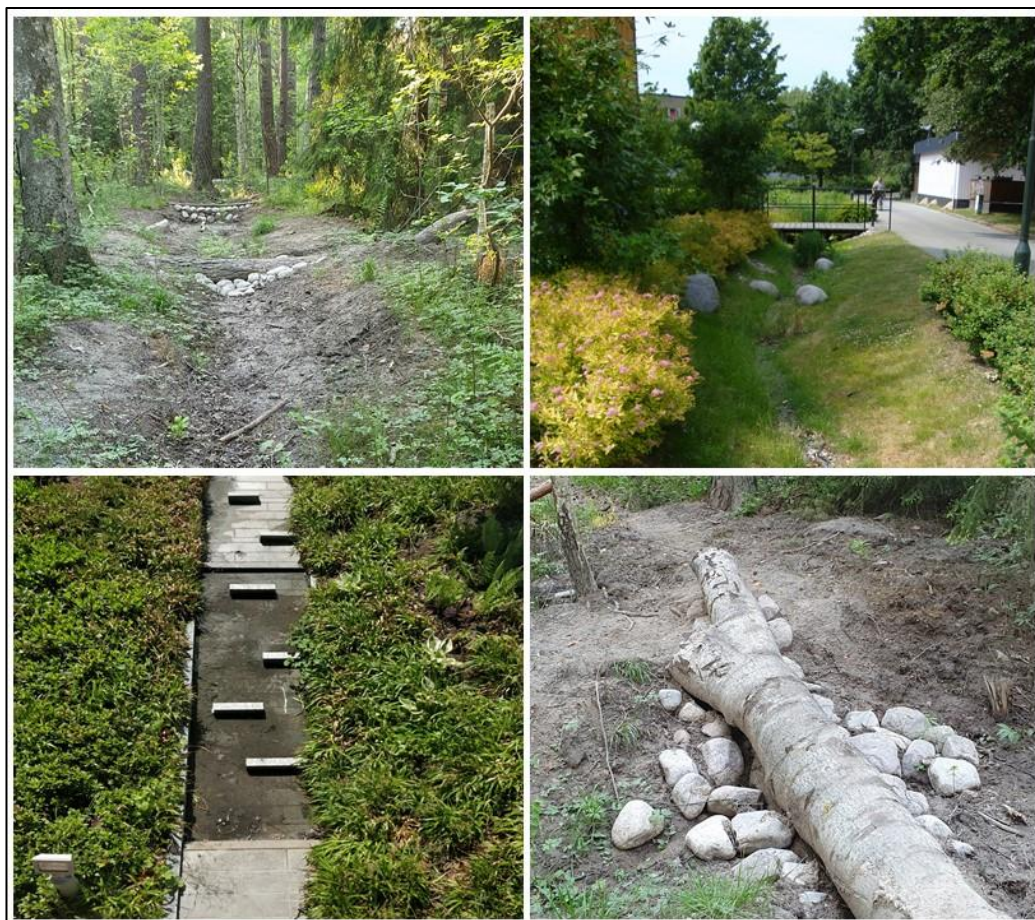
Figur 20: Exempel på hinder i dagvattendiken. Foto Sweco.
