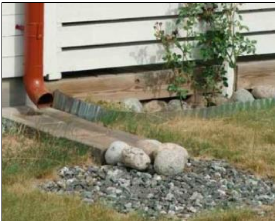
Figur 15: Stuprörutkastare med rännalsplattor och erosionsskydd som leder ut vattnet på gräsmattan. Foto: Dagvattenhandbok, Haninge kommun 2019.
