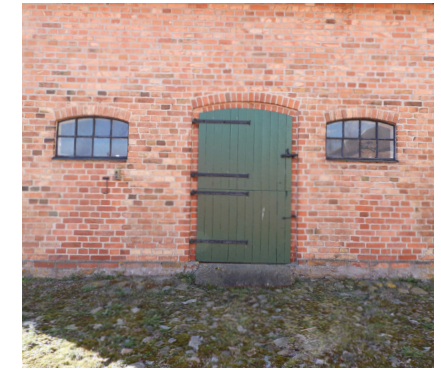
Detalj av norra fasaden, utgång mot gödselstacken. Under fönstren syns igenmurade luckor för grisarna.
