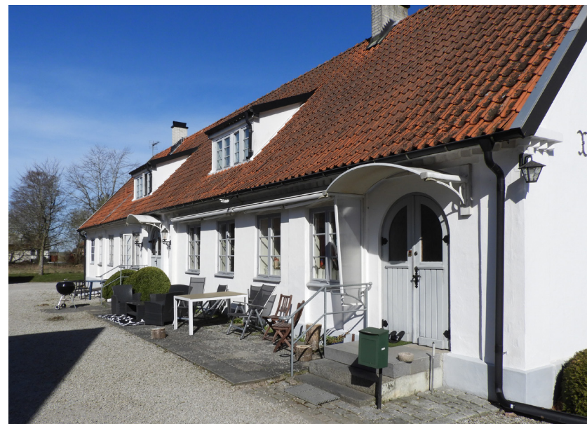
Gårdsfasaden med sidoentrén närmast i bild.
