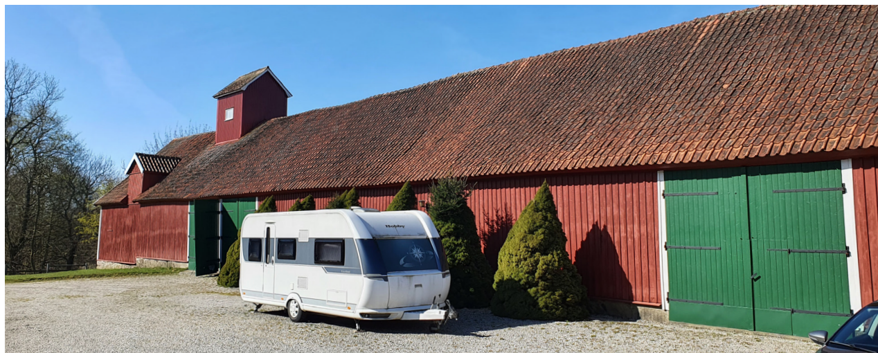
Logens fasad mot gårdsplanen.
