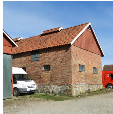
Svinstallets södra fasad och östra gavel.
