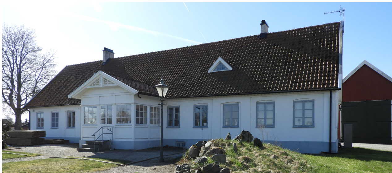
Mangårdsbyggnadens fasad mot trädgården i norr.
