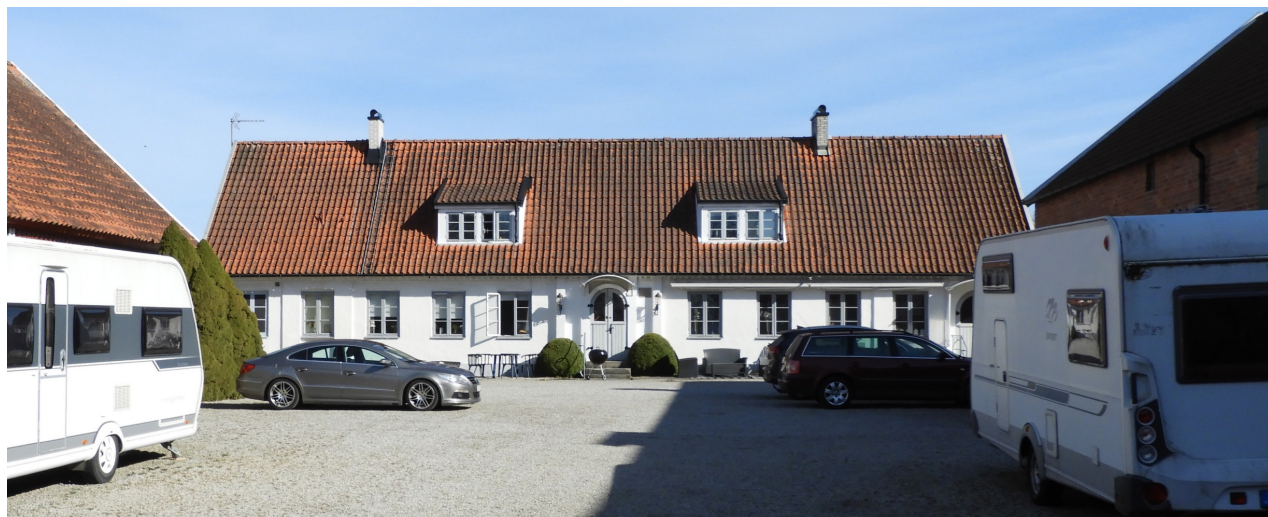
Mangårdsbyggnadens fasad mot gårdsplanen i söder.
