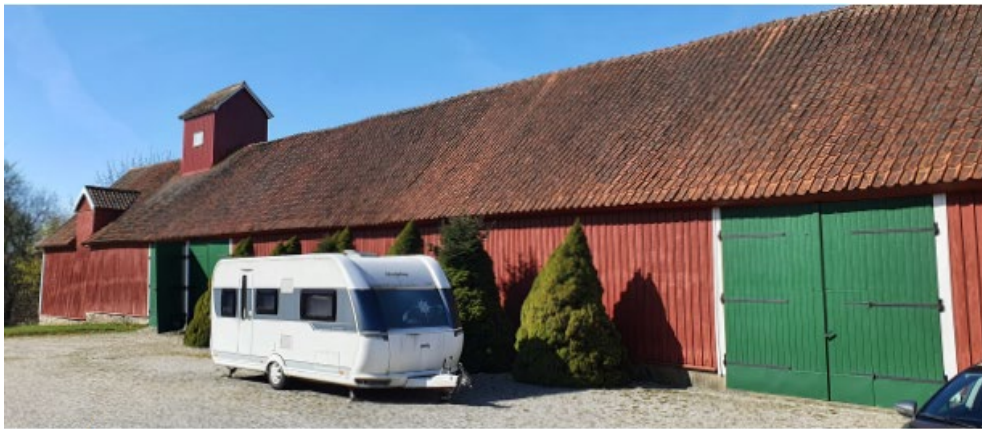
Figur 6. Logen sedd från nordöst. Bild från kulturmiljöutredning.
