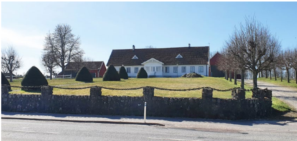
Figur 9. Trädgården sedd från Gårdstångavägen i norr. Bild från kulturmiljöutredning.
