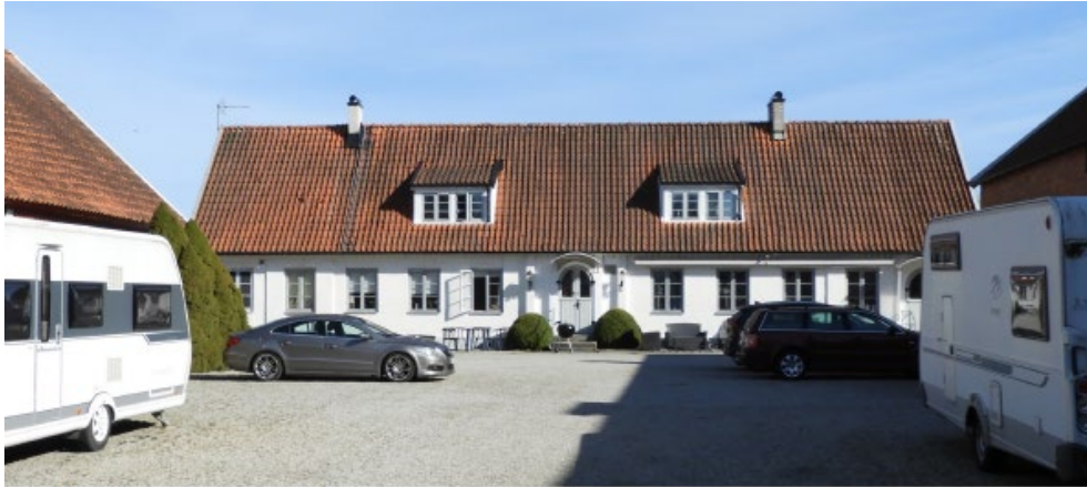
Figur 4. Mangårdsbyggnad sedd från söder. Bild från kulturmiljöutredning.
