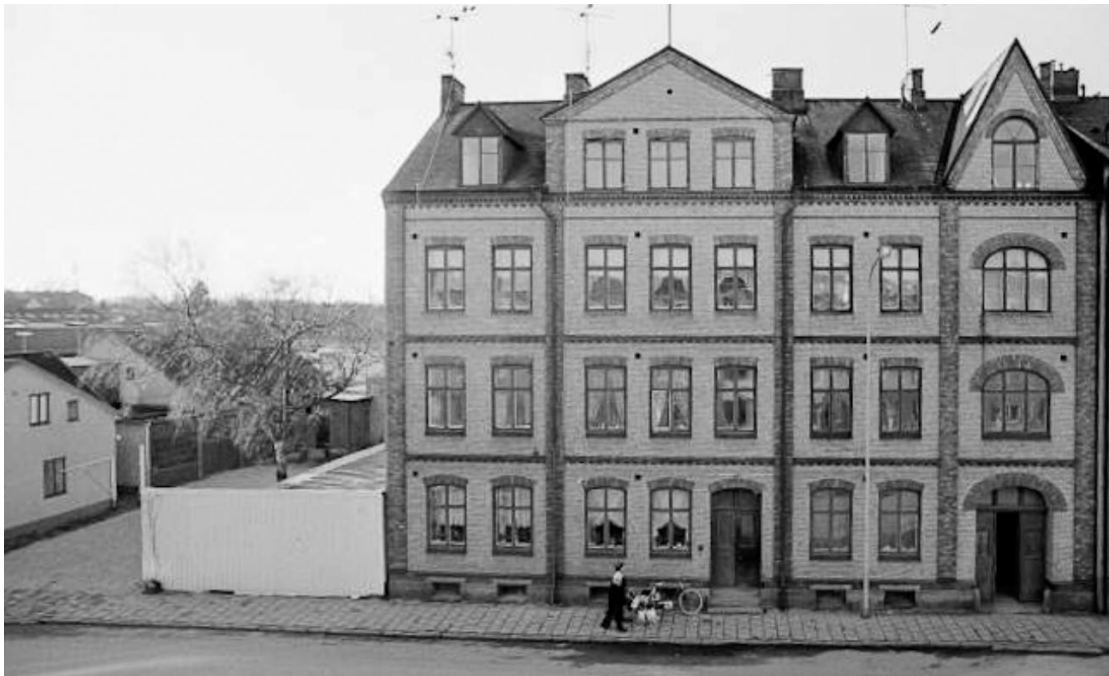
Figur 11. Byggnad på Sebran 37 - östra fasaden mot Västerlånggatan
