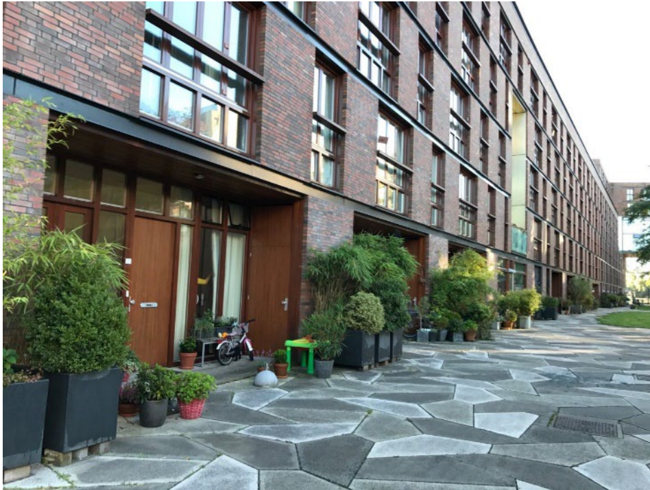
Figur 9. Entréer som är halvprivata mot gård. Bostadsområde i Amsterdam. Bild: Radar
