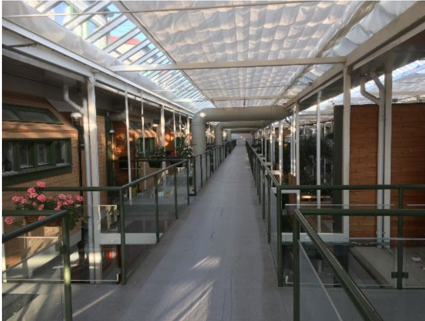
Figur 17. Inre loftgång i den befintliga byggnaden
