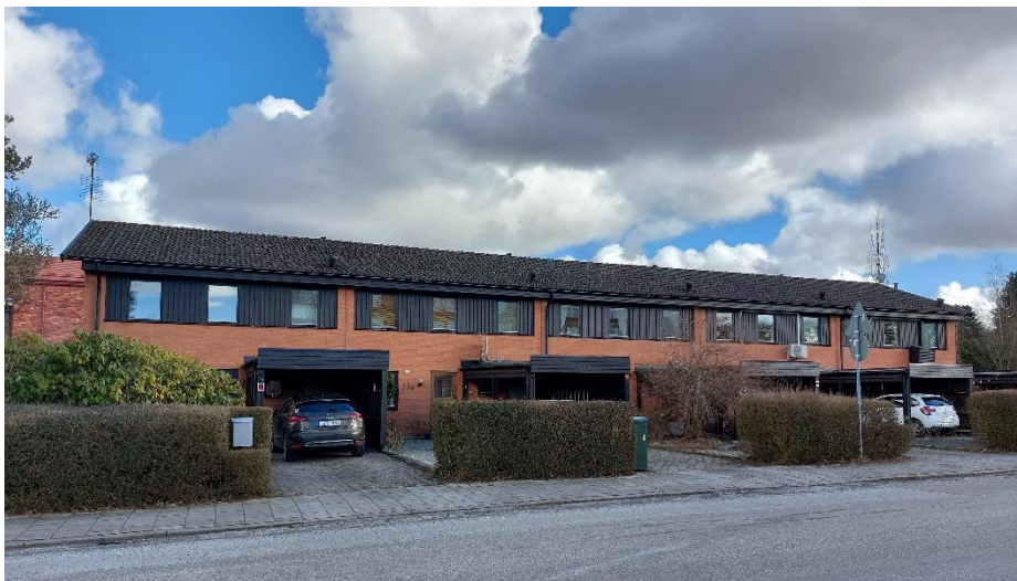
Figur 6 Befintlig bebyggelse inom Utkiken 2, vy från Skolgatan.
