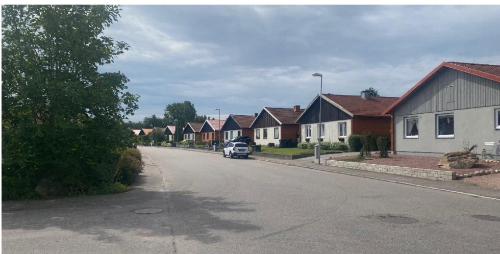
Figur 8. Vy över småhusbebyggelse i den södra delen av Ystadsvägen.
