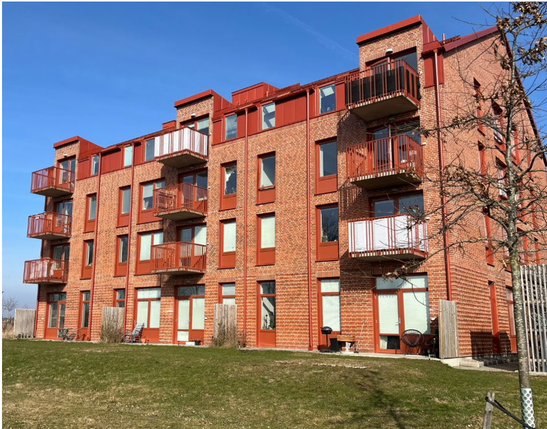
Figur 9. Referensbild på byggnad där all byggnadsplåt samspelar med fasaden och är av samma röda kulör.
