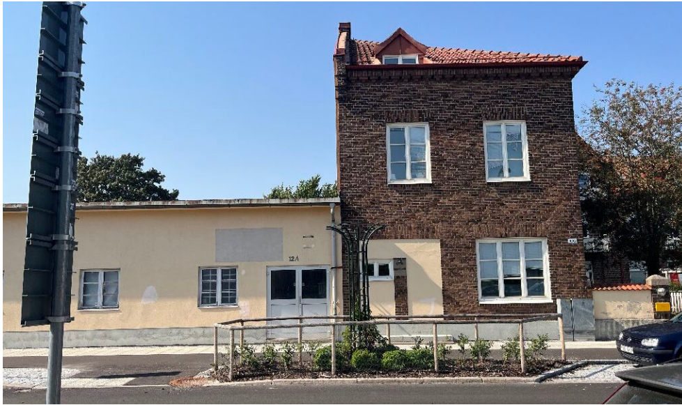
Figur 14. Den röda tegelbyggnaden, del av det gamla mejeriet, som ansluter till befintlig byggnad inom planområdet.
