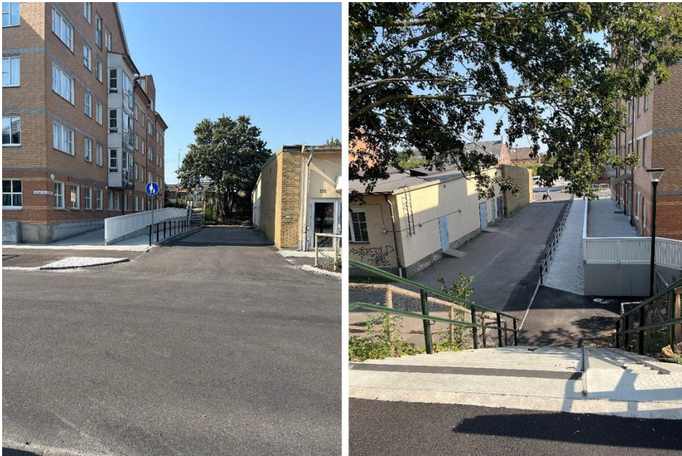
Figur 4. Gångvägen och trappan som kopplar samman järnvägsstationens pendlerparkering med Kvarngatan samt går mellan fastigheterna Abborren 2 och Abborren 15.
