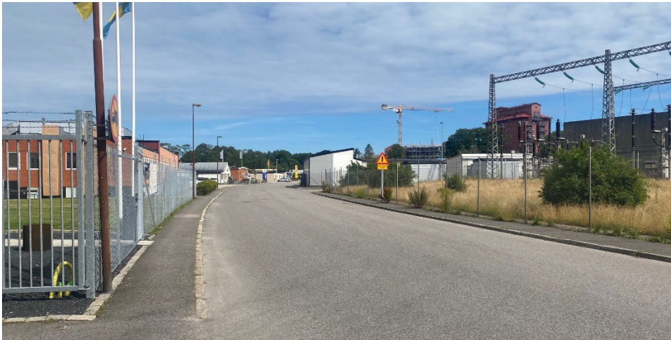
Figur 7. Vy över småindustrin, ställverket i den norra delen av Ystadsvägen.
